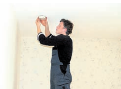
Rauchmelder, Notrufsysteme und Blitzschutz sorgen für Sicherheit.
